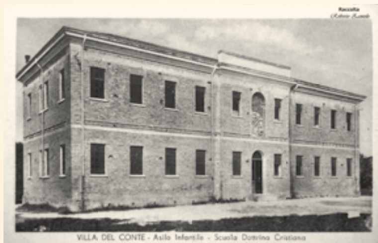
L'edificio dell'asilo dove ha sede anche la casa della Dottrina Cristiana (1944).
